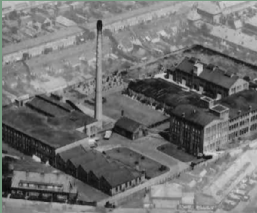
Luchtfoto van de inktfabriek
